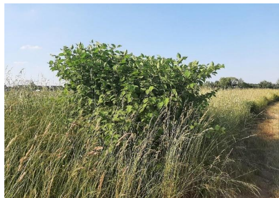
Figuur 4-77 Japanse duizendknoop op de waterkerende dijk
