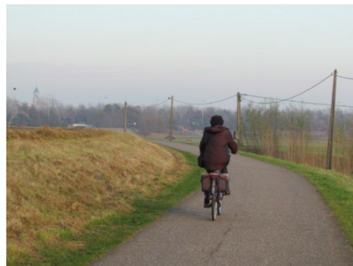
Noordelijke weg in dijkhelling
