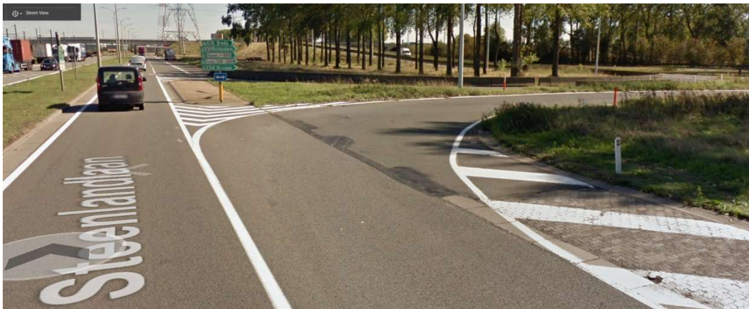
Figuur 3-46: Oprit richting Zelzate vanaf de Steenlandlaan
