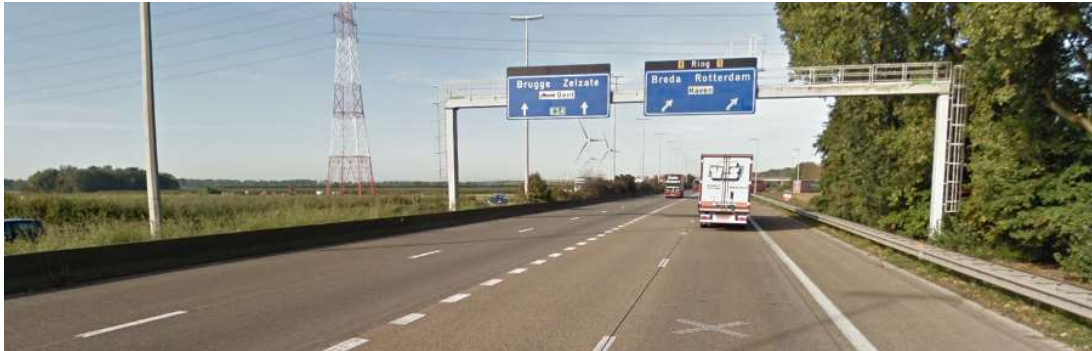
Figuur 3-43: E34 tussen wisselaar R2xE34 en complex Melsele komende vanuit het oosten
