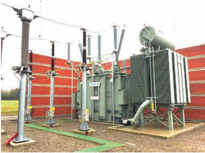
↑ Figuur 13 Shuntreactor
