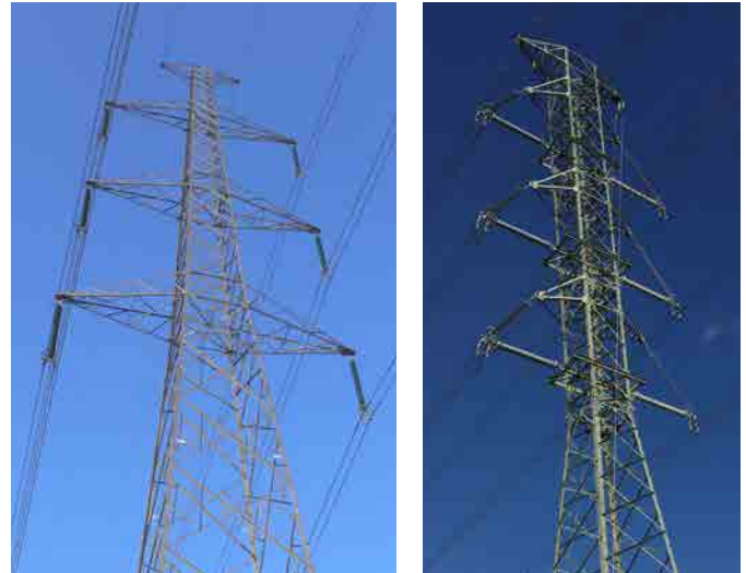
↑ Figuur 5 Tweebundel 2x900 HTLS (links) en vierbundel 4x707 AMS-2Z (rechts)
