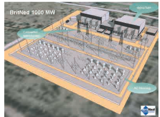
↑ Figuur 19 Voorbeeld van een LCC-conversiestation
