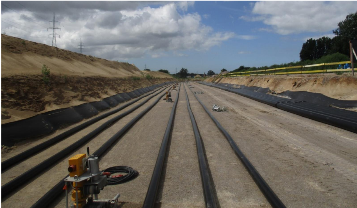
Figuur 4-5: werfzone van een ondergrondse aanleg van een 380 kV-verbinding
