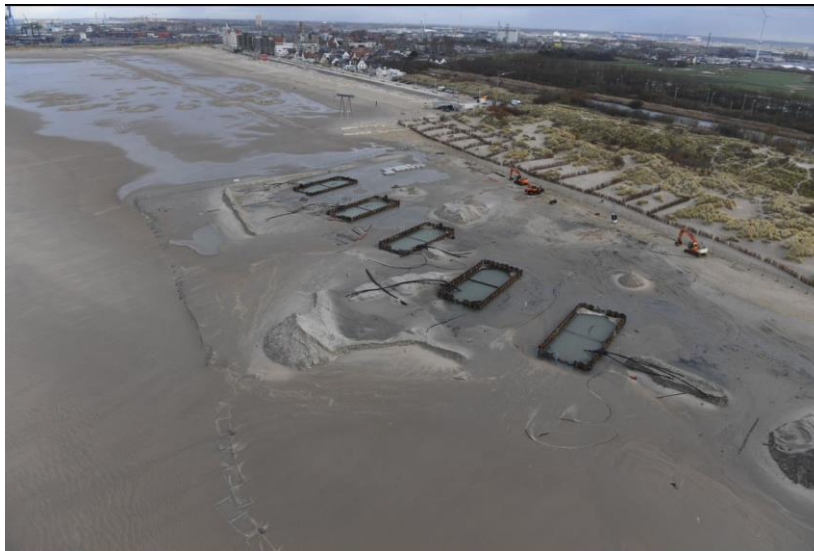
Figuur 4-2: luchtfoto van de aanlandingszone in Zeebrugge voor de aansluiting van de 1 ste wave offshore windparken
