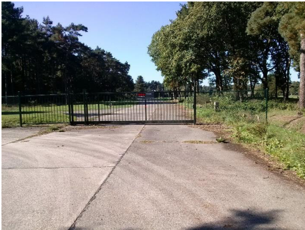
Figuur 26: Zicht op de toegang vanuit de Britselaan (grondgebied Westerlo)
