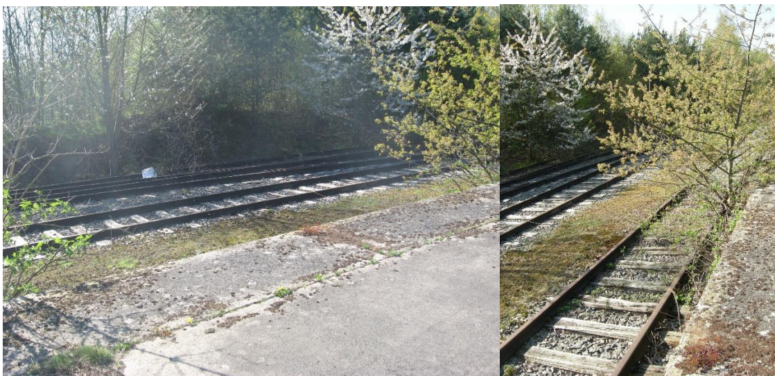
Figuur 3 Voormalige spoorwegbedding (Venheide)
