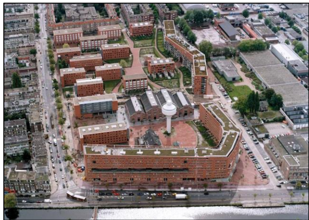
Figuur 14 - Voorbeeld afschermende werking van een gebouw (Waterwijk, Amsterdam)
