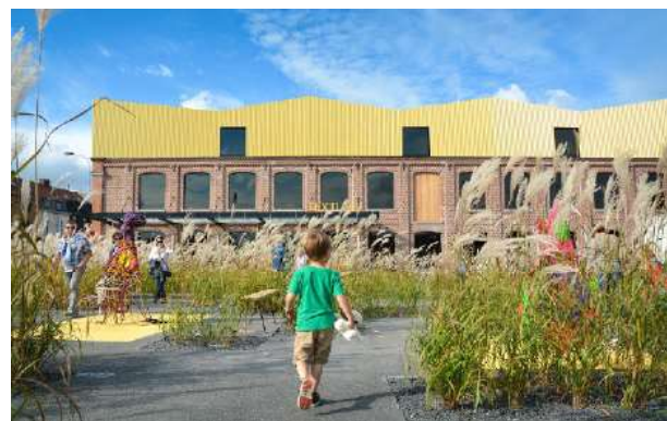
VANDAAG IS TEXTURE, HET VLASMUSEUM VAN KORTRIJK, ONDERGEBRACHT IN EEN VOORMALIGE TEXTIELFABRIEK LANGS DE LEIE
