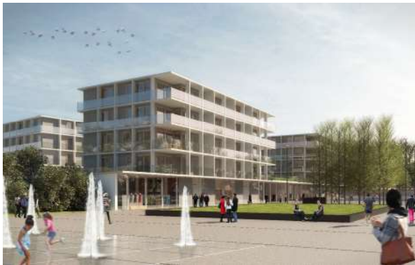
STADSVERNIEUWING ZUID-BOULEVARD WAREGEM
