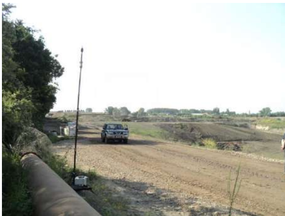
Meetpunt MP1, einde eigen terrein
