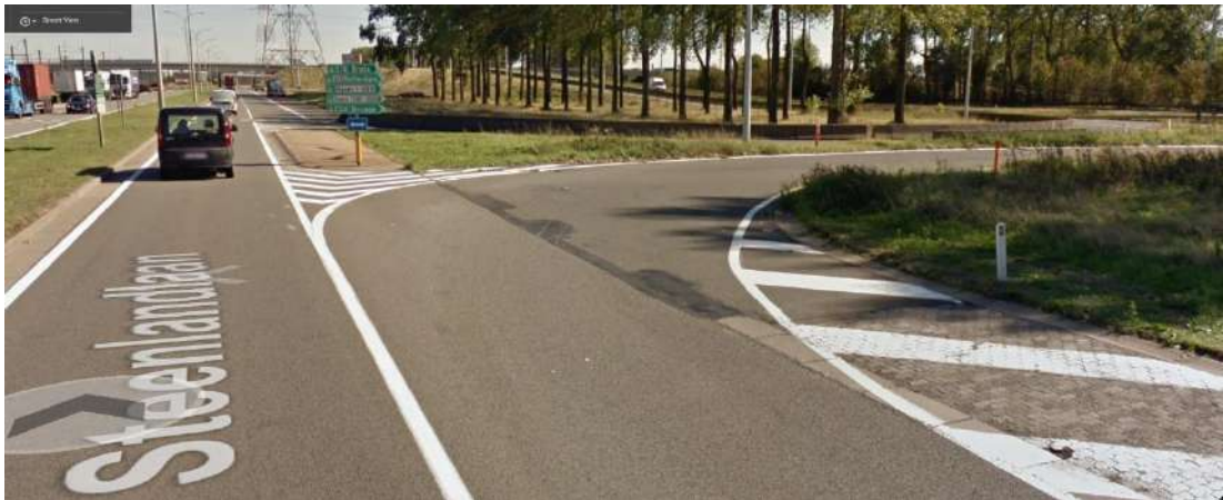
Figuur 6-28 Oprit richting Zelzate vanaf de Steenlandlaan
