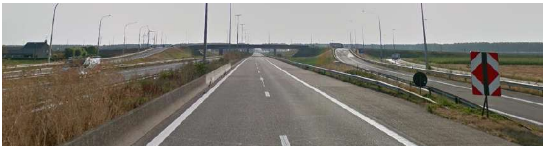
Figuur 6-20 Complex Vrasene komende vanuit het westen
