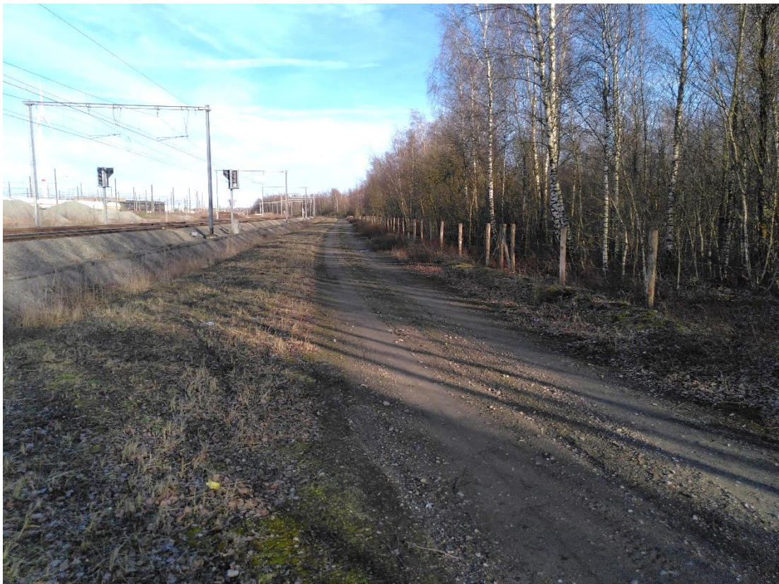
Figuur 5-5 Huidige noodweg in halfverharding, met links het rangerstation en rechts zone Haasop
