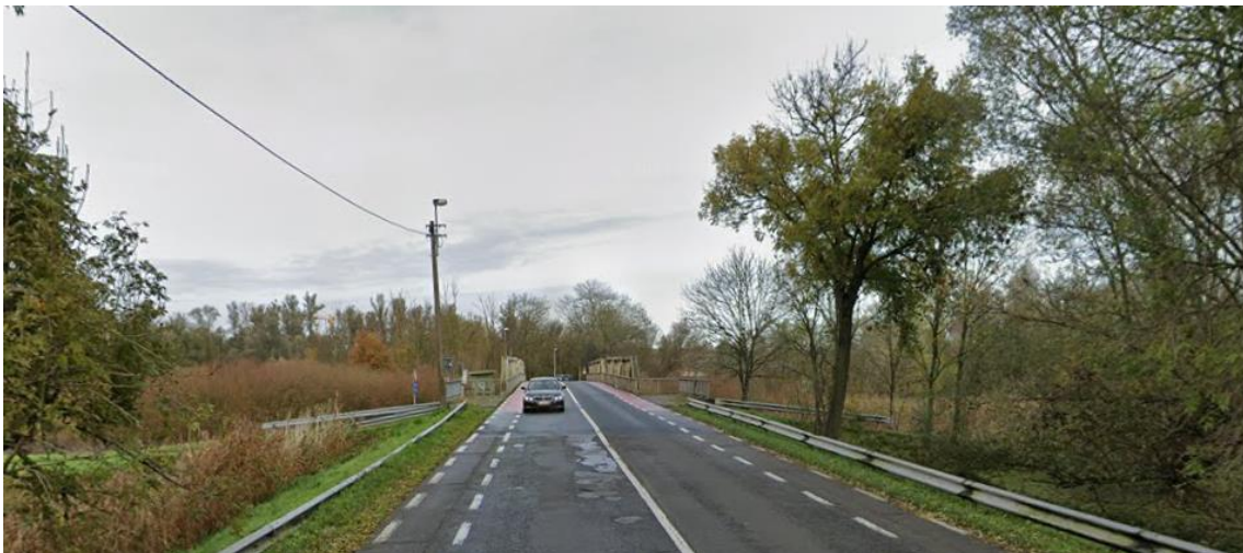
Afbeeldingen roestende, beschadigde brugonderdelen met ernstige corrosieschade:
