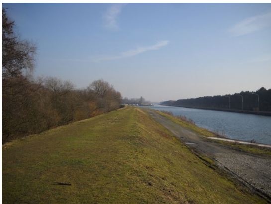
Zicht op de jachthaven en het Netekanaal
