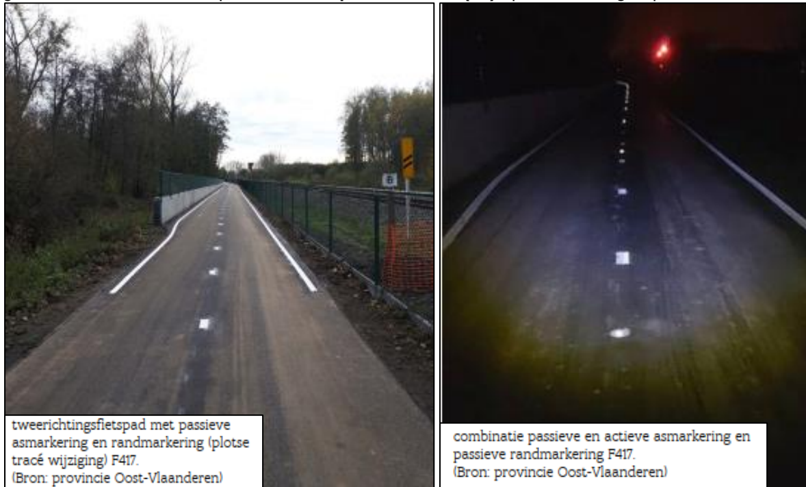
Figuur 1-20: actieve en passieve bebakening, voorbeelden fietsostrades Oost-Vlaanderen
