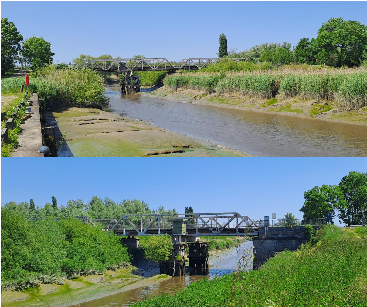
Figuur 2-6: Foto's van de Durmebrug.
