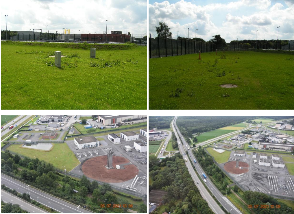
Figuur 6-68 Foto's compressiestation te Zelzate
