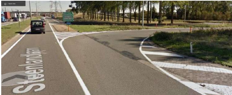
Figuur 6-28: Oprit richting Zelzate vanaf de Steenlandlaan
