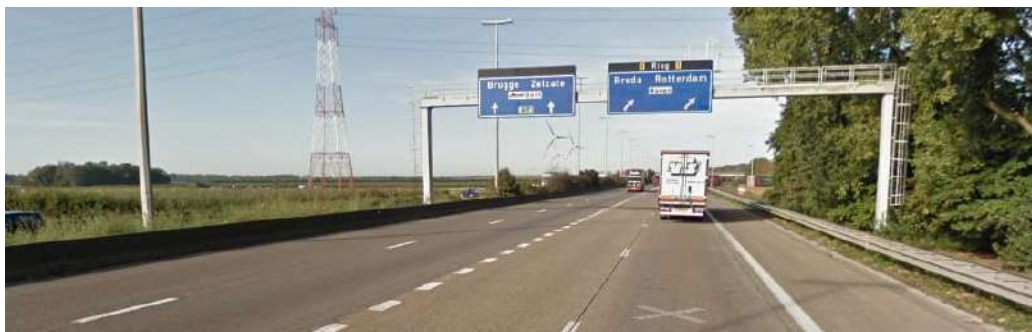
Figuur 6-25: E34 tussen wisselaar R2xE34 en complex Melsele komende vanuit het oosten
