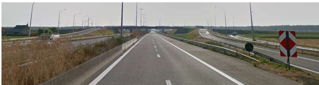
Figuur 3-38: Complex Vrasene komende vanuit het westen
