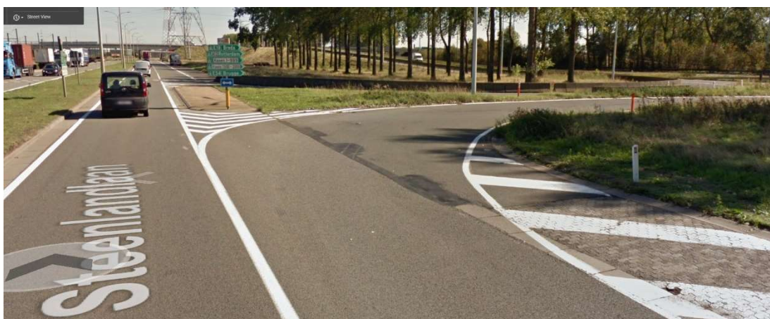
Figuur 3-46: Oprit richting Zelzate vanaf de Steenlandlaan
