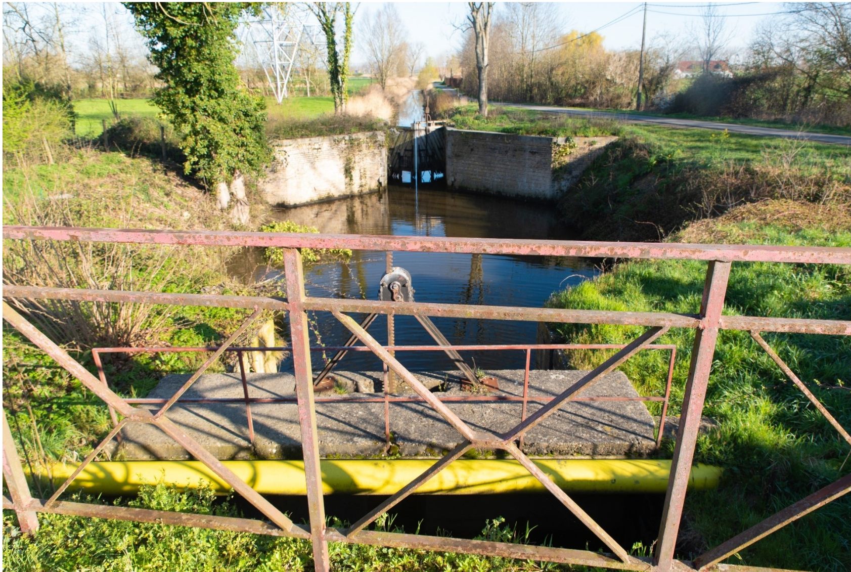
Figuur 2: Zicht op Speisluis, Fotoarchief VLM (2023).
