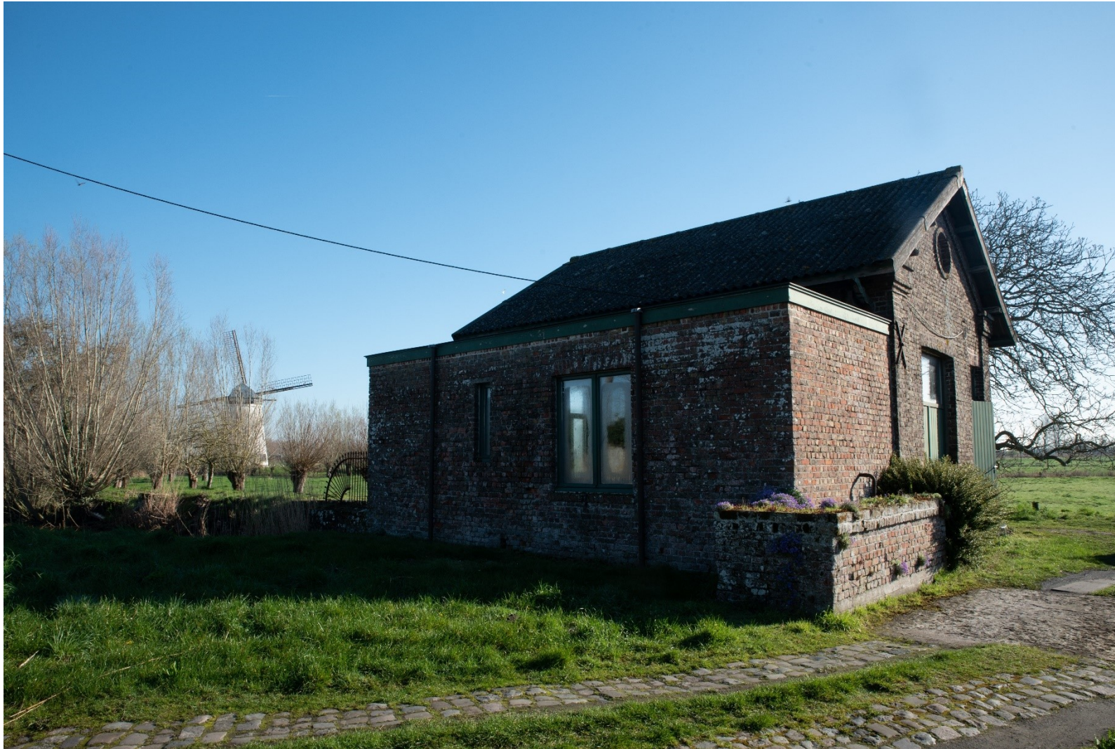
Figuur 3 Zicht op pompgemaal Meetkerke (Fotoarchief VLM, 2023)
