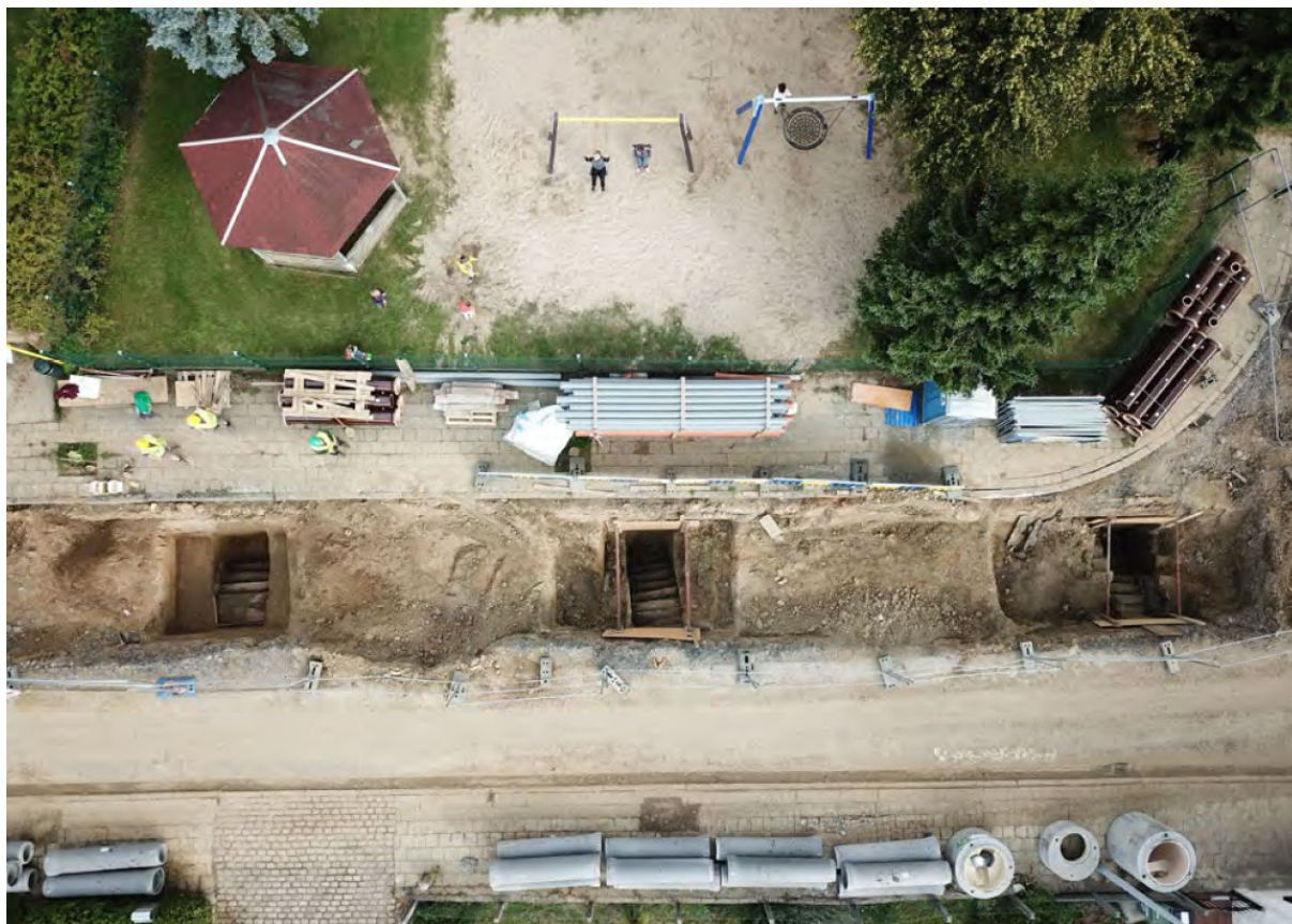
Fig. 5.55: Wijtschate - Hospicestraat: luchtopname van de drie westelijke tunneltoegangen tot de ondergrondse schuilplaats (@ agentschap Onroerend Erfgoed, foto Raph De Brant).
