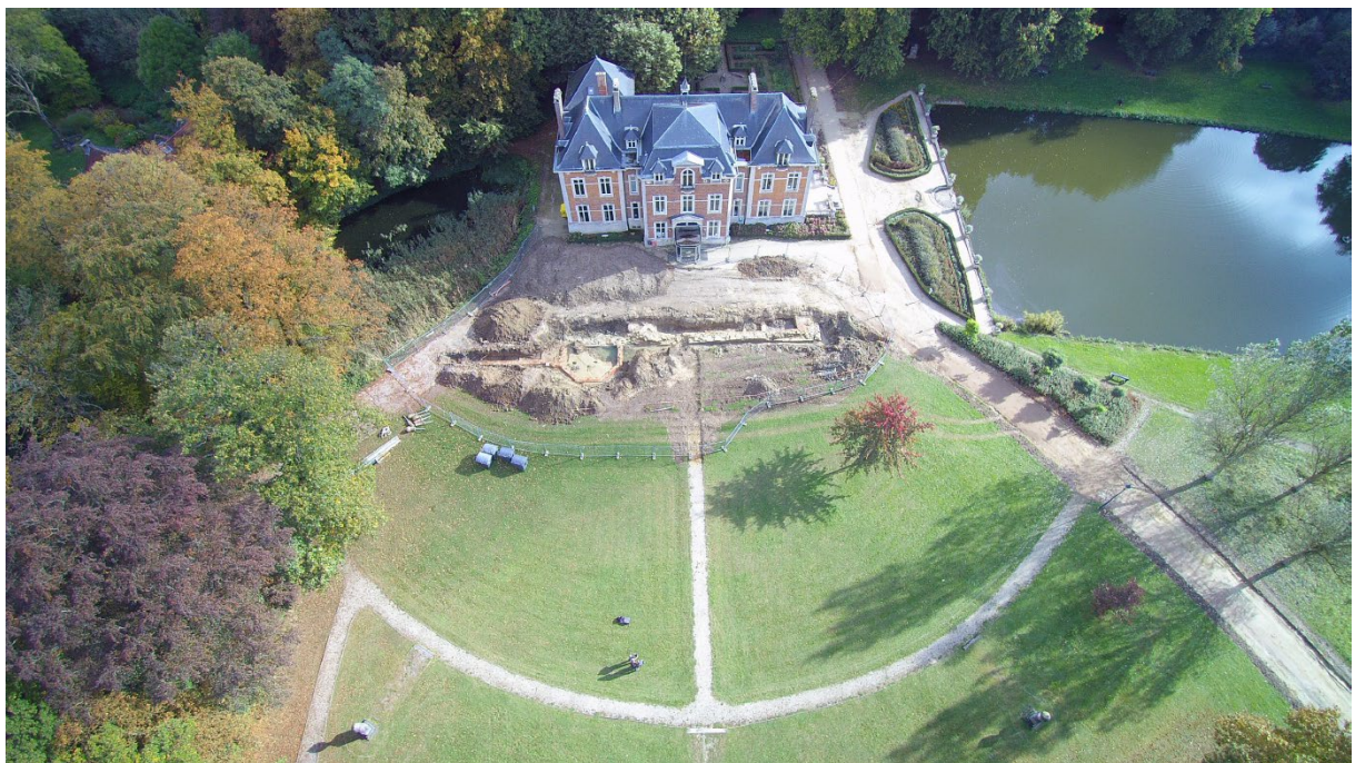
Fig. 5.52: Verrijck, Boutersem: Luchtfoto vanuit het noordoosten tijdens de opgraving van het kasteel van Kwabeek (© Gemeente Boutersem).
