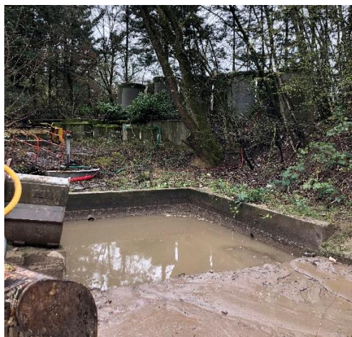
Figuur 2.10 Wateropslag op de site (cfr. Antea Group, 2023).
