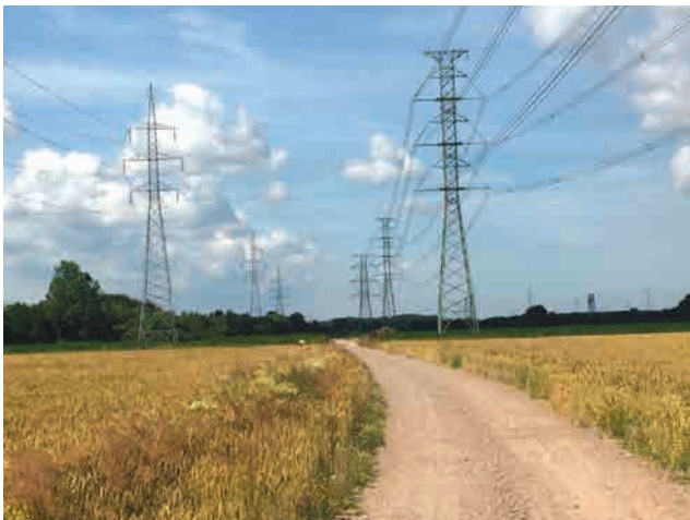
→ Figuur 8 www.stevin.be Compact 380kV-silhouet t.o.v. klassiek 380kV-silhouet (links) en 150kV-lijn t.o.v. compacte 380kV-lijn (rechts)
