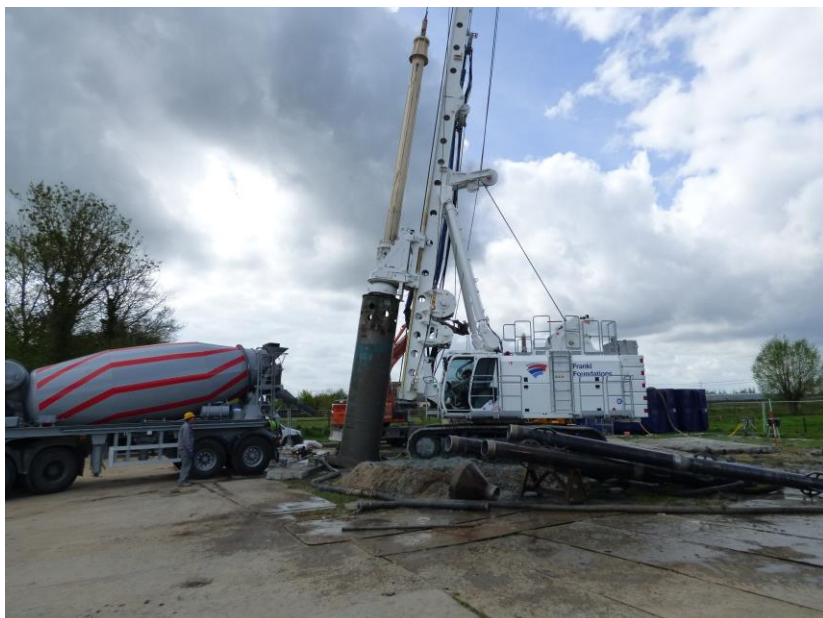
Figuur 3: Voorbeeld van uitvoering van boorpalen voor een mastfundering
