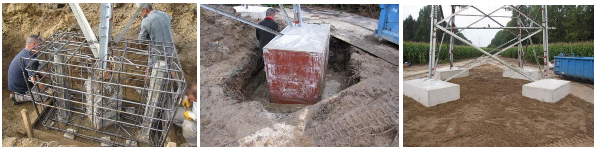
Figuur 7: Voorbeeld van versterking van fundering met micropaal
