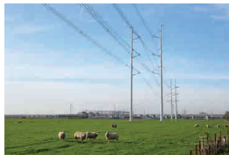
← Figuur 9 Wintrackmasten: dubbele buismast of bipodemast (NL) (links) en Eagle Tower: enkele buismast of monopodemast (DK) (rechts)
