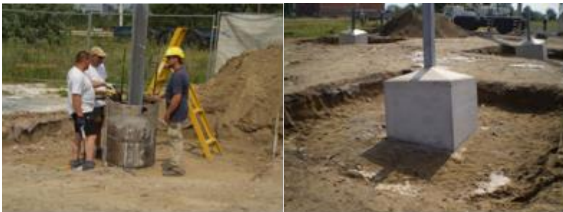
Figuur 5: Plaatsen van verankeringsprofielen en realiseren van een bovengronds massief
