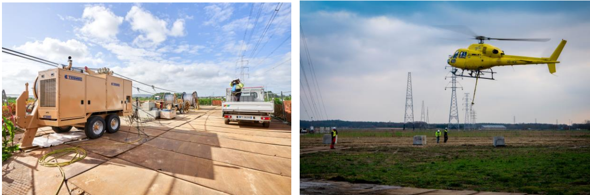
Figuur 10: Voorbeeld van mobiel remstation (links) en helikopter met trekkoord (rechts)
