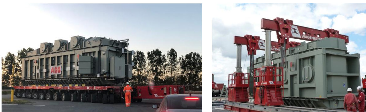
Figuur 24: Transport van een dwarsregeltransformator over de openbare weg en het lossen op het hoogspanningsstation
