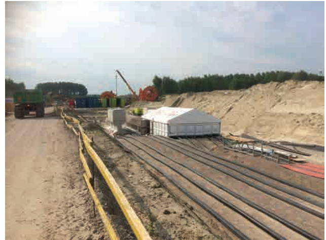
↑ Figuur 11 Kabelsleuf voor een 380kV-kabel (4 circuits) (rechts)
