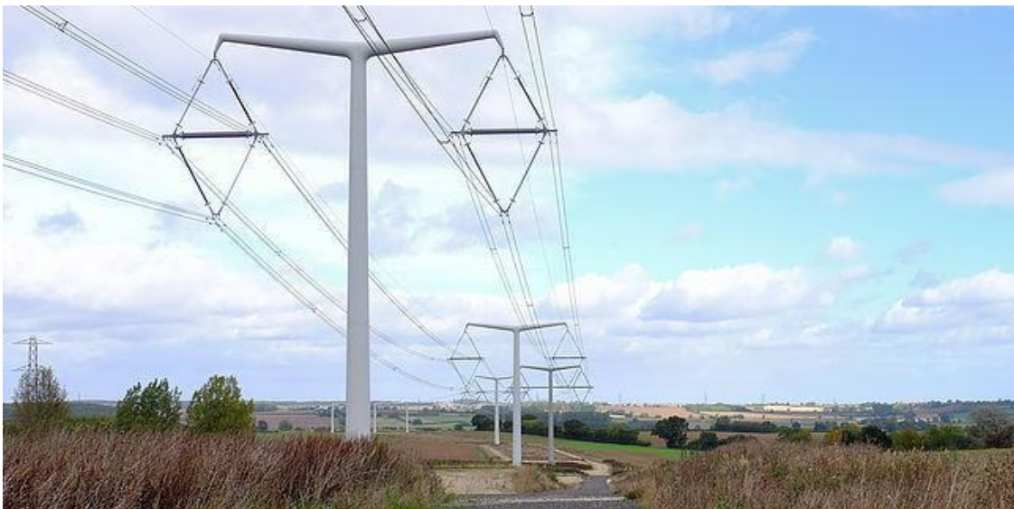
Figuur 6: Structuur van gevouwen staal van 380 kV
