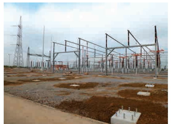
↑ Figuur 39 Zijaanzicht van een standaard 380kV-veld
