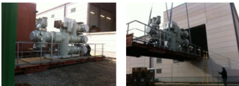
Figuur 23: Binnen brengen van een GIS-installatie
