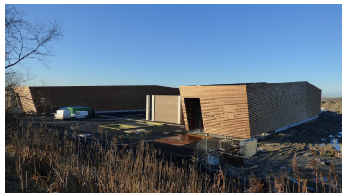
Station Stevin, Zeebrugge, België - archiles architecten
