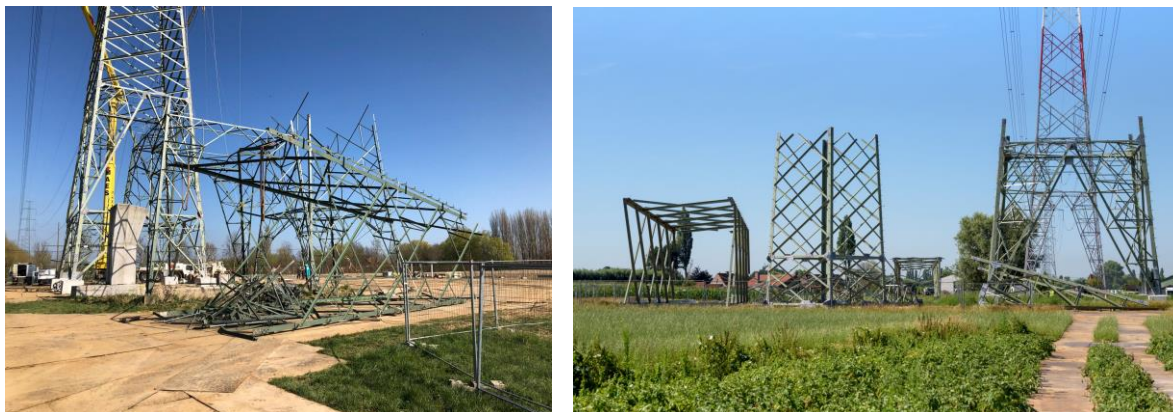
Figuur 8: Geassembleerde mastdelen in de werfzone
