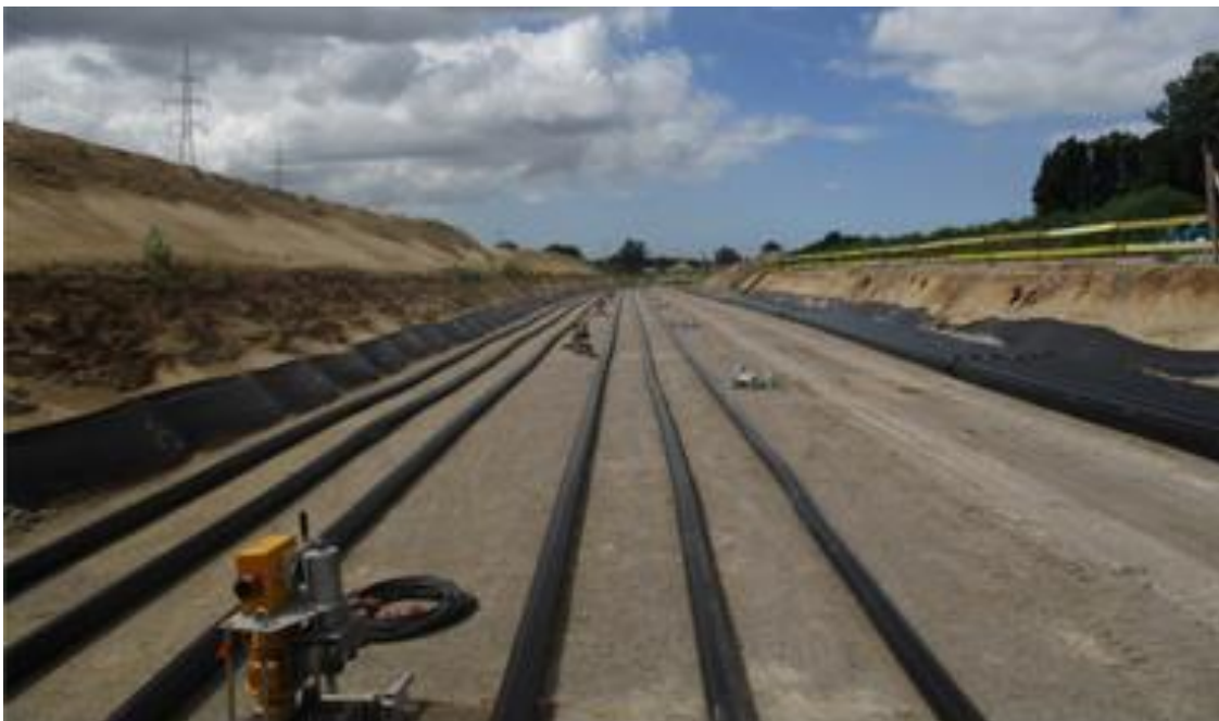
Figuur 6: Circuit van direct ingegraven kabels van 380 kV vóór opvulling
