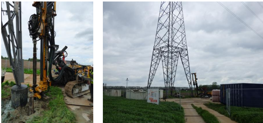
Figuur 6: Versterking van funderingen met micropalen
