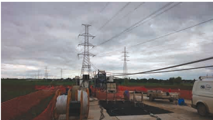
↓ Figuur 36 Voorbeeld van een werfzone voor het trekken van geleiders
