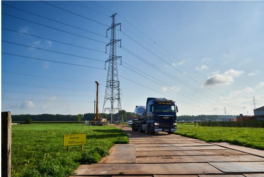
Figuur 2: Voorbeeld van rijplaten in de werfzone
