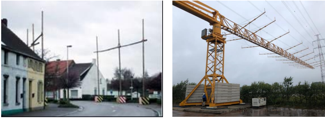
Figuur 9: Voorbeeld van beschermingsportieken (links) en beschermingskraan (rechts)
