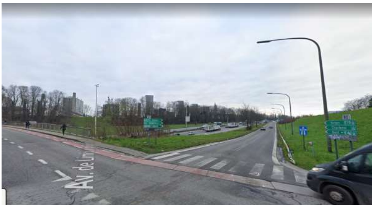
Figuur 559: Zicht vanop de De Limburg Stirumlaan – bestaande toestand (bron: Google maps)
