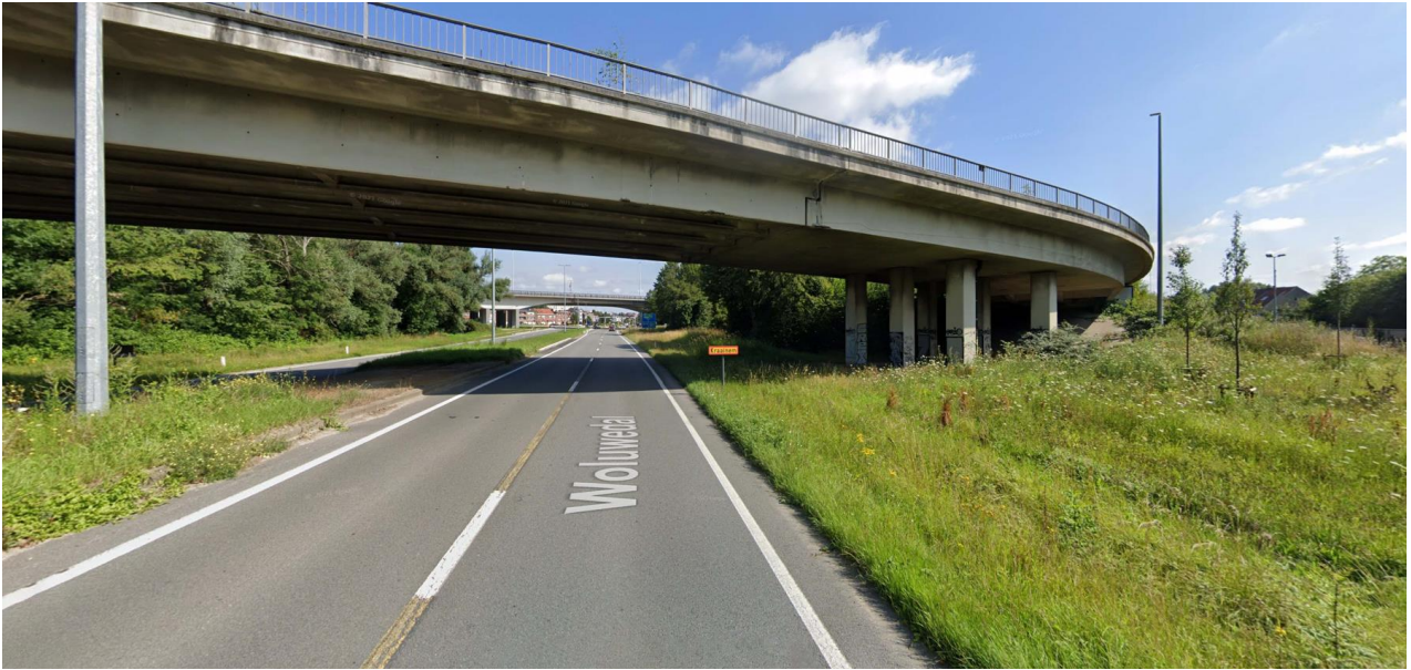
Figuur: bestaande toestand vanop Woluwedal t.h.v. het aansluitingscomplex 20 in Kraainem
