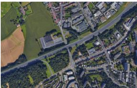
Foto: Aansluitingscomplex 9 Jette (bron: www.google.be/maps )
