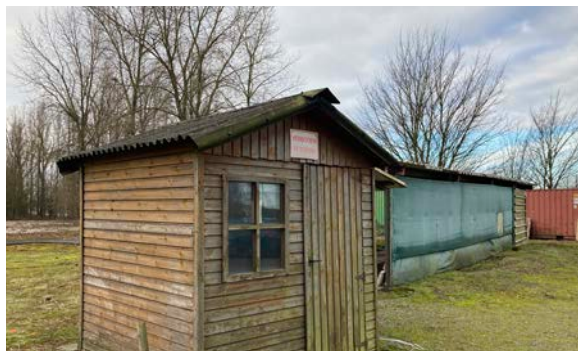
14 - chalet waar batterijen worden opgeladen
