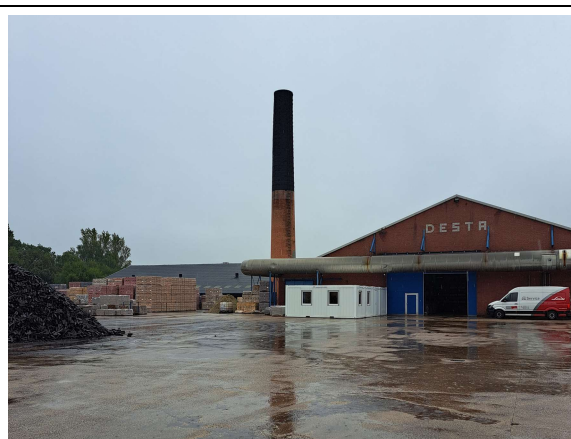
Foto vanuit het noorden van het terrein naar de bedrijfsgebouwen
