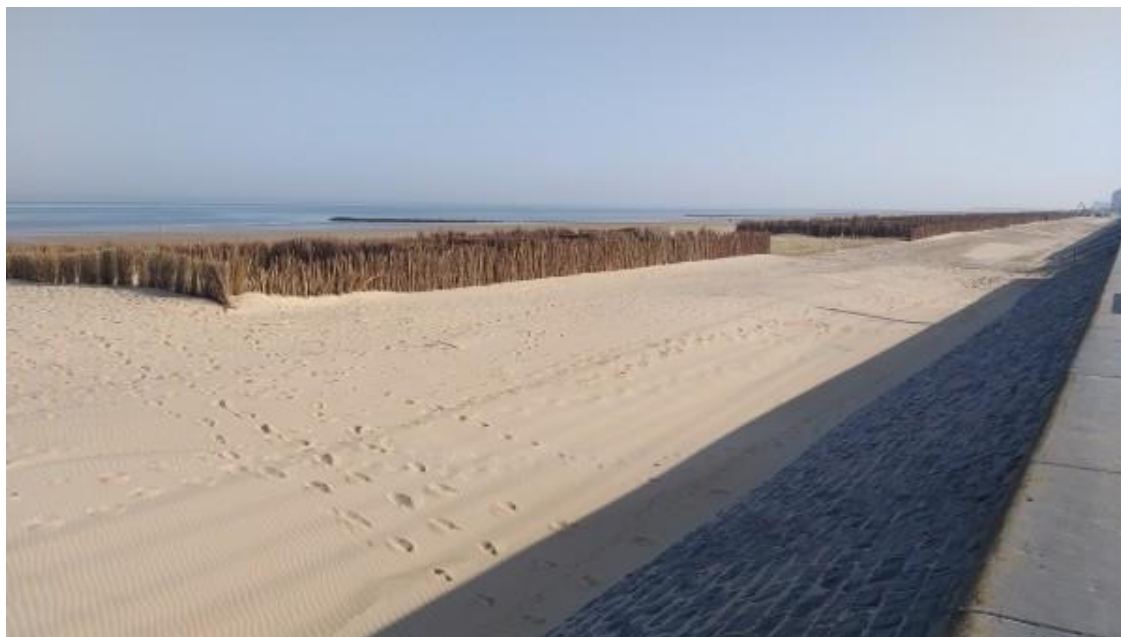
Figuur 5-5: Rijshouthagen bij het duin voor dijk project in Raversijde, voorjaar 2021 (bron: agenschapmdk.be)
