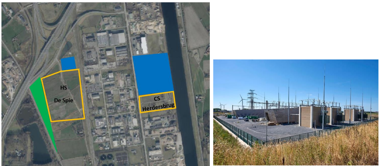
figuur 5-4: Schematische voorstelling hoogspanningsstation De Spie en convertiestation Herdersbrug (uitbreiding: geel, bestaande infrastructuur: blauw, groengebied: groen) / rechts: foto bestaand hoogspanningsstation
