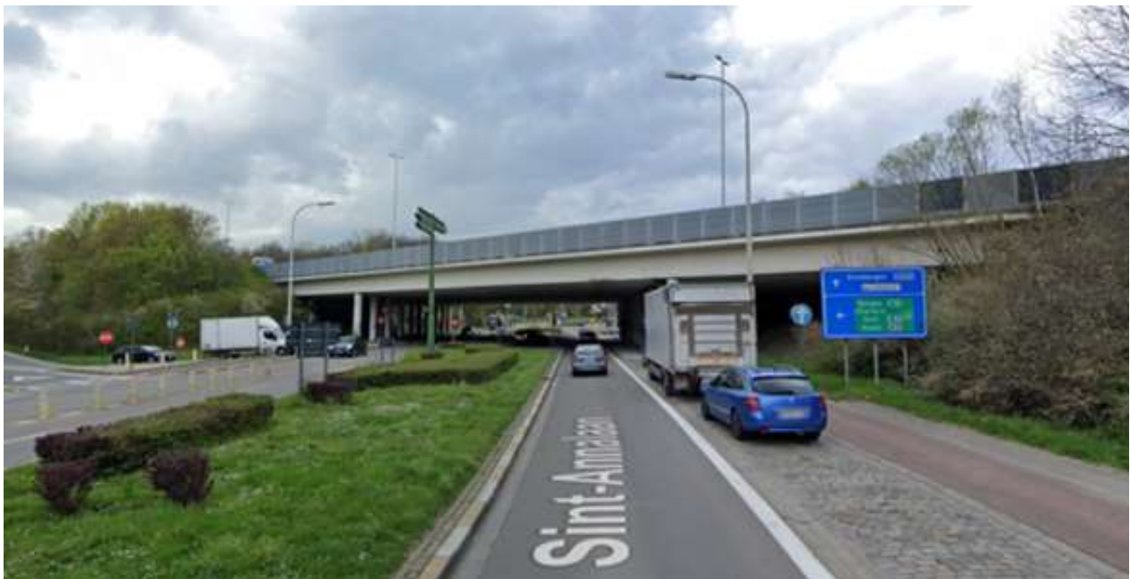
Figuur: bestaande toestand onderdoorgang Sint-Annalaan onder de Ring
