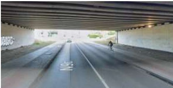
Foto 1: N9c Brusselsesteenweg t.h.v. doorgang onder R0 (bron: google.be/maps )
