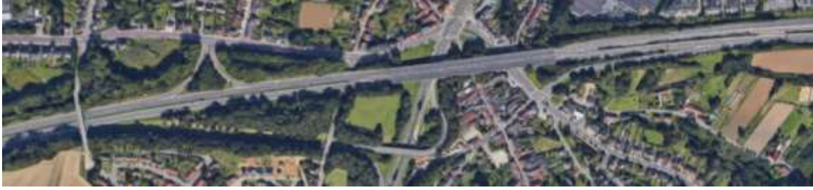
Foto: Aansluitingscomplex 20 op de A3/E40 in Kraainem (bron: www.google.be/maps )
