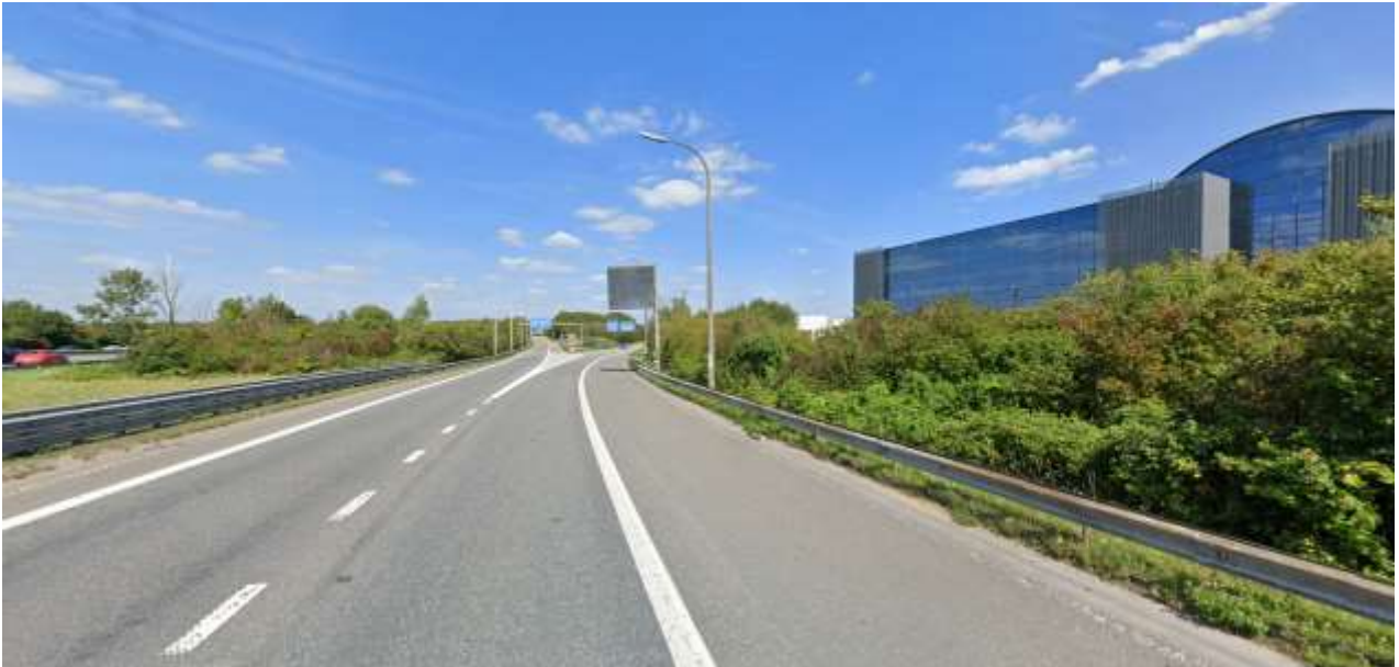
Figuur: bestaande toestand verkeerswisselaar R0xE40 Groot-Bijgaarden, gezien vanuit de binnenring
