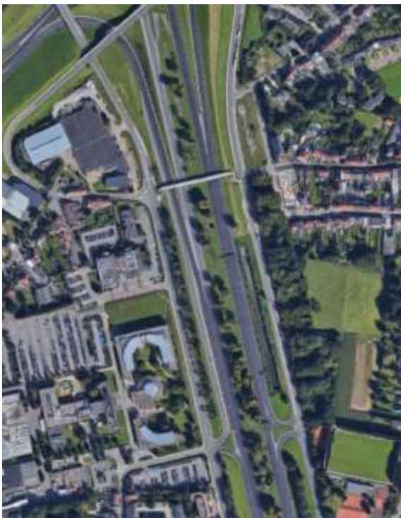
Foto: Aansluitingscomplex 2 op A12 Strombeek-Bever (bron: www.google.be/maps )
