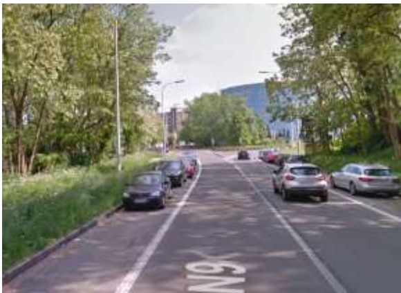
Foto: N9 t.h.v. aansluiting met A10 (bron: www.google.be/maps )
