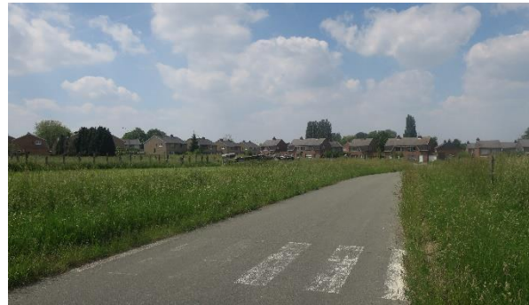
Zicht op de aangelegde wegenis in het plangebied en de aanpalende woningen.
