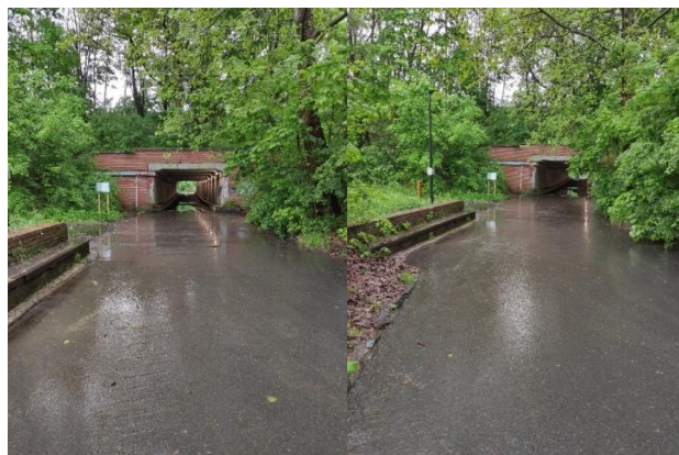
Figuur 3.72: Impressie fietsinfrastructuur Wellemeersenstraat: fietstunnel (Bron: Terreinbezoek 9-05-2023).
