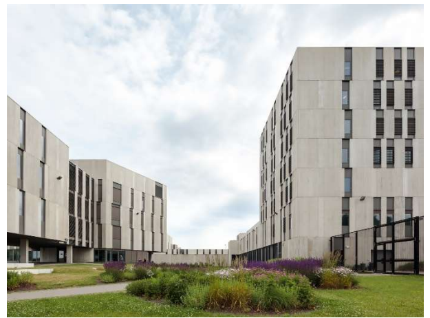
FPC Antwerpen ter hoogte van de groene buitenruimte tussen de gebouwen.
