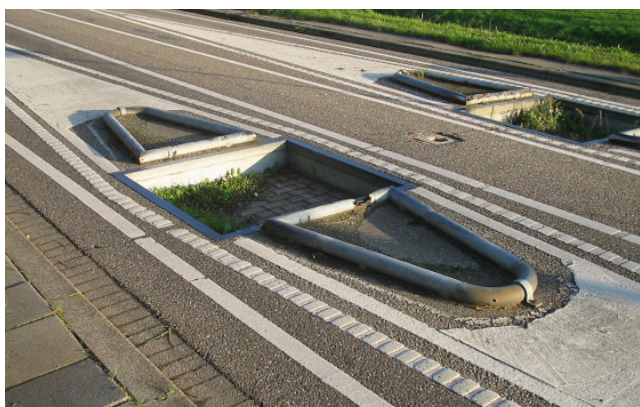
Een busluis is een aanpassing aan het wegdek waardoor enkel bussen kunnen passeren. Gewone auto's of vrachtwagens kunnen niet passeren. Een busluis zorgt voor een betere doorstroming van bussen.
