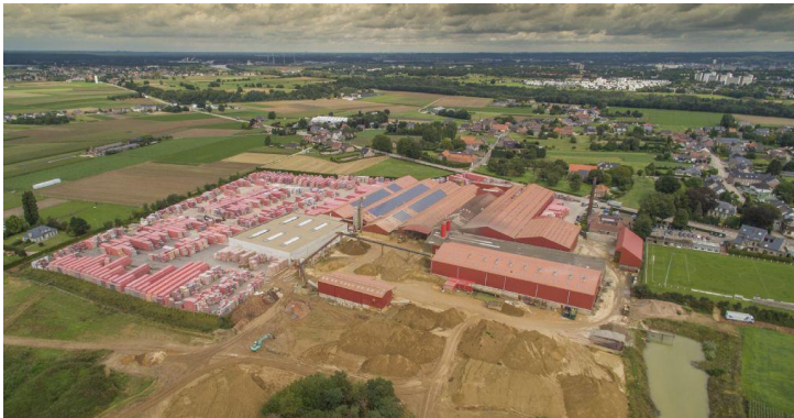
Figuur 2: Vooraan de opslag van de grondstoffen. Centraal de kleine loods waar de kleivoorbereiding gebeurt.
