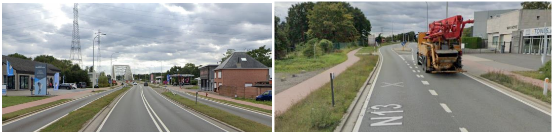
Figuur 7-23: Vrijliggende fietspaden N152 (links) en N13 (rechts) (bron: Google Maps)
