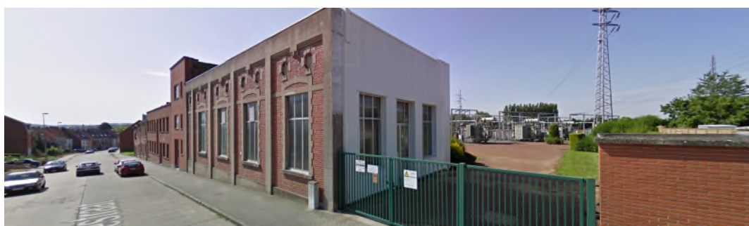
Transformatorstation van Elia, grenzend aan tracés I7, G4 en T2
