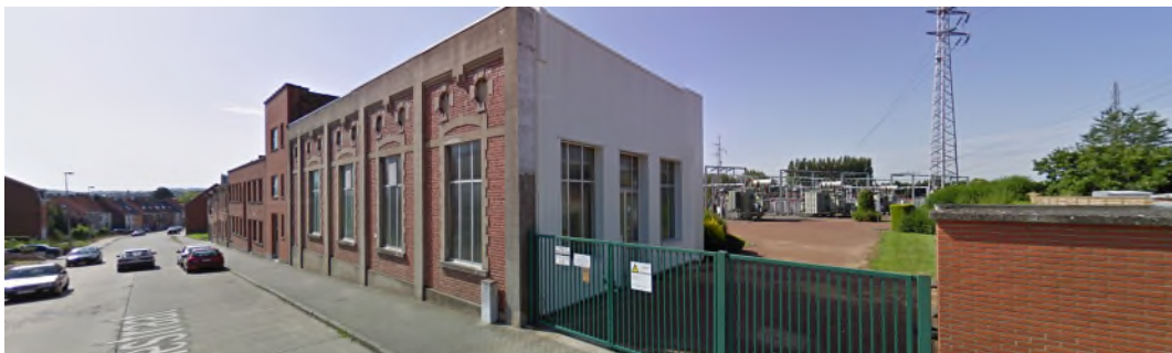
Transformatorstation van Elia, grenzend aan tracé G4plus
