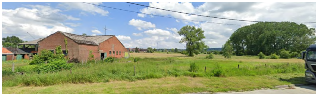
Zicht vanaf de Saint-Sauveurstraat richting oosten op de reservatiestrook (Cité Stookt op de achtergrond)
