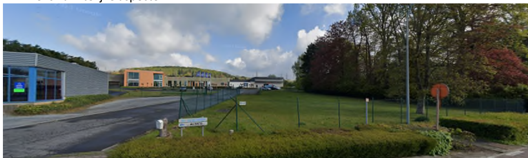
Bedrijf Alsico, geïmpacteerd door tracé C1
