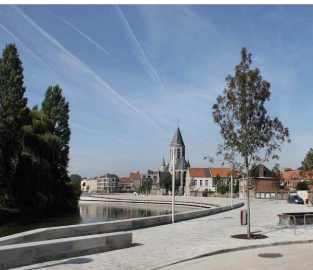
Verlaagde publieke ruimte aan de Leieboorden in Deinze (Marie-José Van Hee & Robbrecht en Daem architecten)
