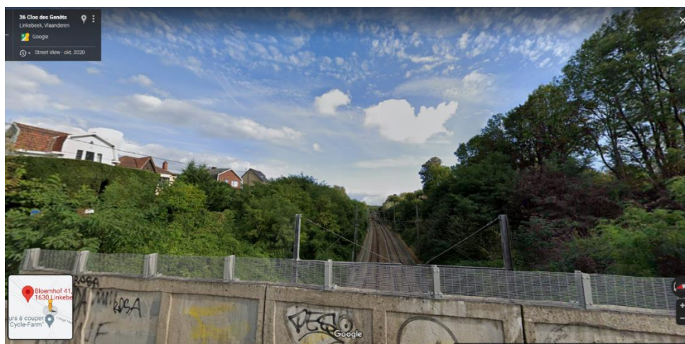
Zicht vanop de huidige brug Kleiveld richting zuiden
