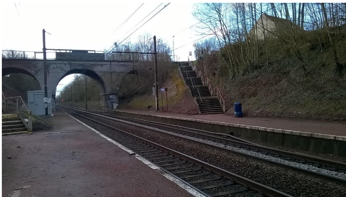
Figuur 9-18: Bestaande overbrugging station De Hoek (Bron: Wikipedia)
