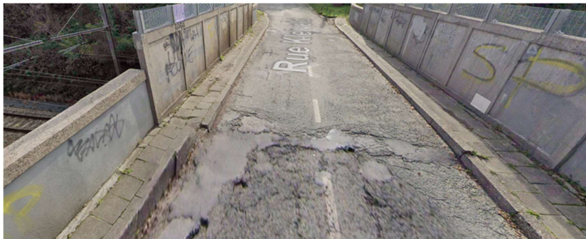
Figuur 3: Huidige toestand brug Kleiveldstraat. Bron: Google Street View
