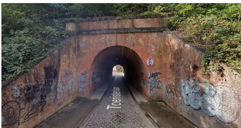
Figuur 12: Tunnel boomkweekerijlaan-toeristenlaan. Bron: Google Street view
