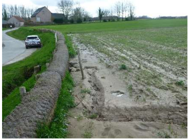
Dammen uit plantaardige materialen zoals stro, kokos, wilgentenen of houthaksel maken dat afstromend water wordt afgeremd en het meegevoerde sediment achter de dam wordt opgevangen. Wordt best geplaatst in combinatie met een grasstrook.
