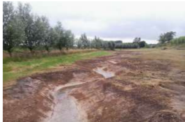
Figuur 14: natuurtechnische oeverinrichting en hermeandering zijn voorbeelden van structuurherstellende maatregelen
