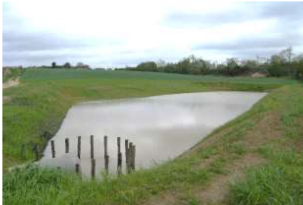
Een depressie of erosiepoel met stroomafwaarts een aarden dam zorgt voor het vertragen van het afstromende water en het bezinken van het sediment (foto: Departement Omgeving).
