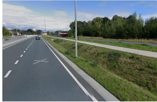
Figuur 3.91: Impressie fietsinfrastructuur R41 ten zuiden van de N9 (Bron: Google Maps, 2023).
