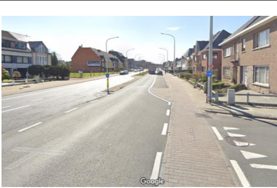
Figuur 3.9: Fietsinfrastructuur R41 aan toegang Biekorfstraat (Bron: Google Maps, 2023)
