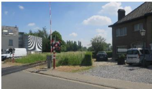
Spooroverweg ter hoogte van de Lindenstraat.
