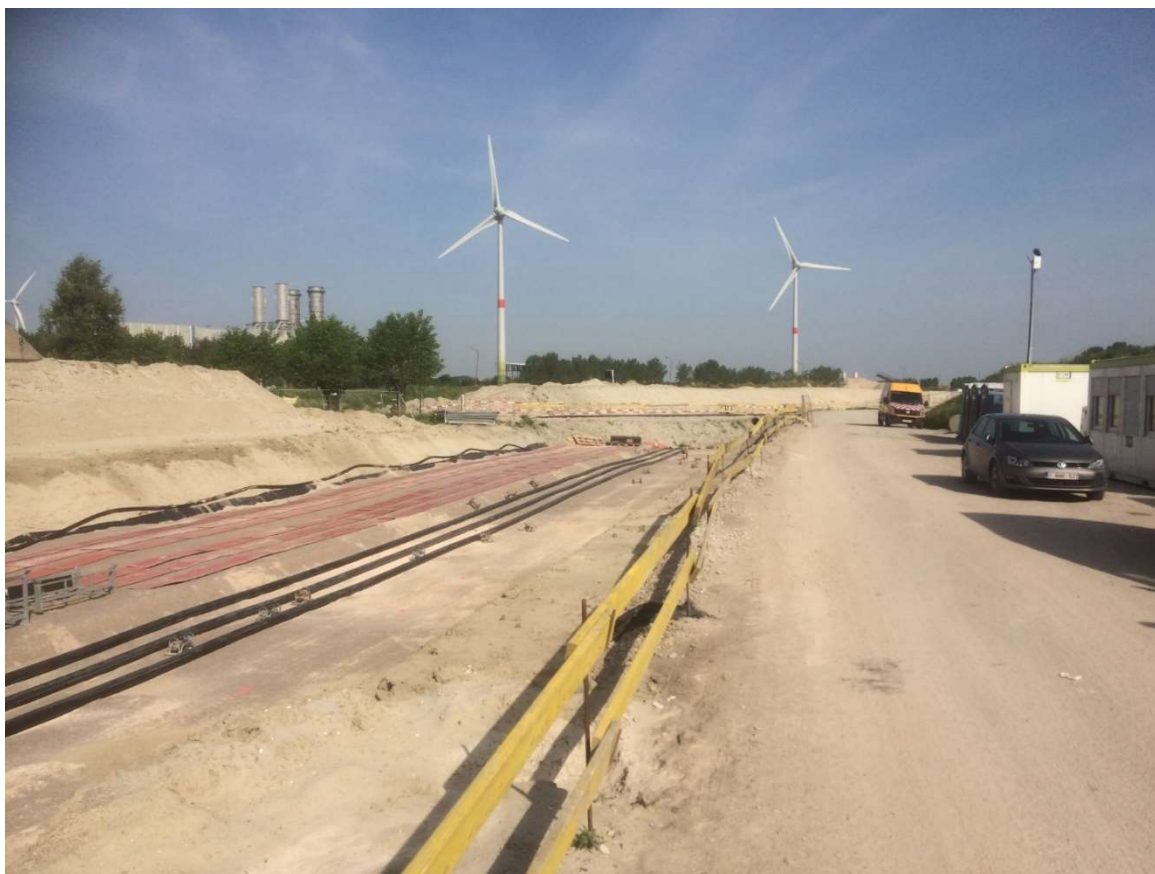
Figuur 8. Open sleuf van een ondergrondse 380kV-verbinding (bron: Elia)
