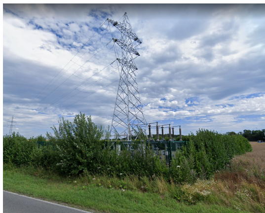
Figuur 13: voorbeeld overgangspost Les Isnes – 150 kV
