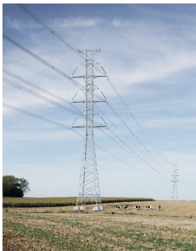
Figuur 6: compacte vakwerkmast
