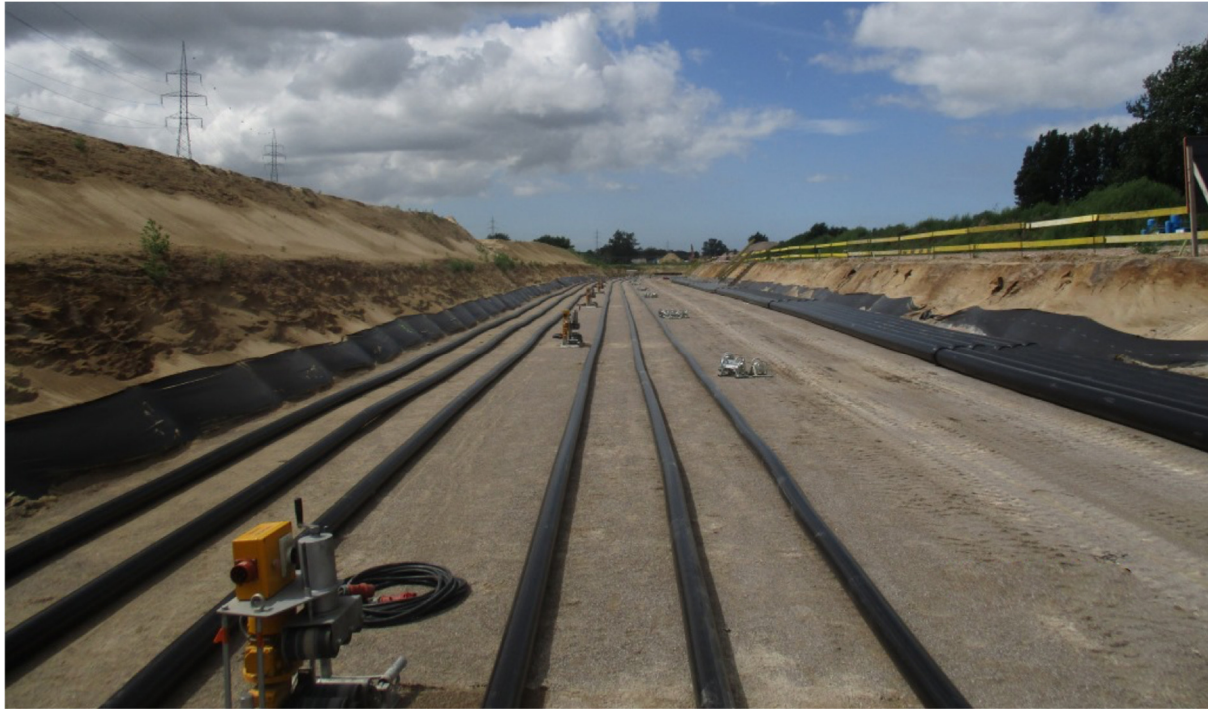
Figuur 11: werfzone van een ondergrondse aanleg van een 380 kV-verbinding (4GW) in open sleuf (Stevin)
