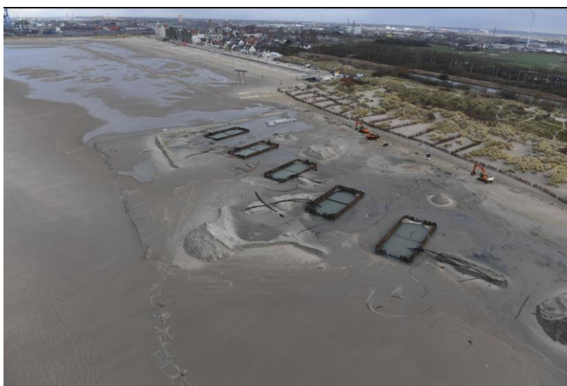
Figuur 15: luchtfoto van de aanlandingszone in Zeebrugge voor de aansluiting van de 1 ste wave offshore windparken
