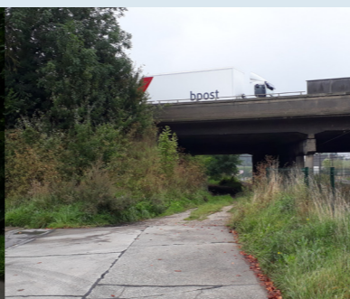
Pad onder viaduct E40 (spoor)
