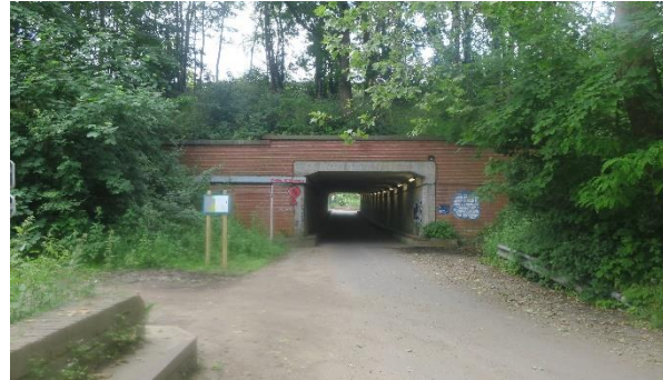
Foto van op de Dokter Carlierlaan richting de doorgang voor langzaam verkeer onder de E40. Links op de foto is de toegang naar het natuurgebied De Wellemeersen te zien.
