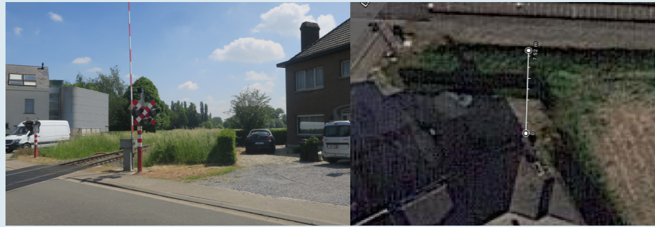
1. Spoorberm tot gevel: ca. 7m - DEELS PRIVAAT - onvoldoende ruimte
