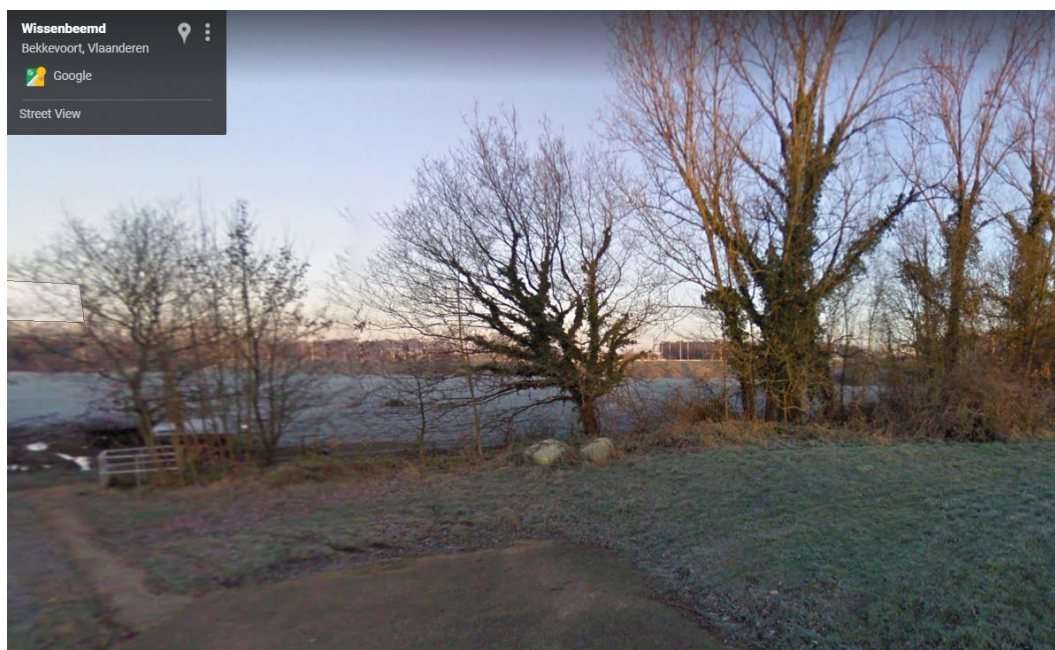
Figuur 3-10: Kruising van het westelijk alternatief en de Begijnebeek ter hoogte van de Wissenbeemd te Bekkevoort (opnamedatum afbeelding 2009, © Google).
