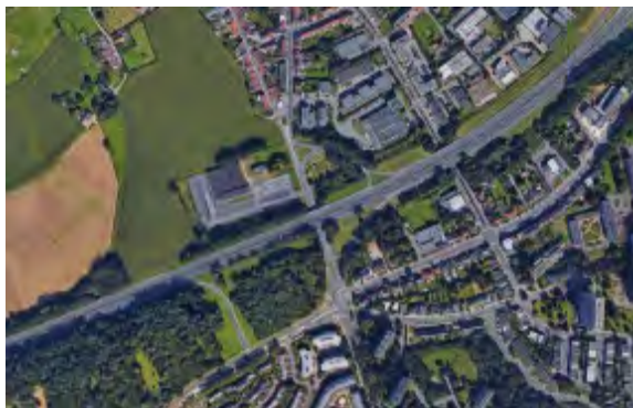
Foto 4: Aansluitingscomplex 9 Jette (bron: www.google.be/maps )
