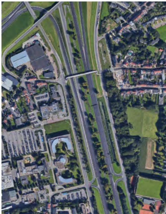
Foto 8: Aansluitingscomplex 2 op A12 Strombeek-Bever (bron: www.google.be/maps )
