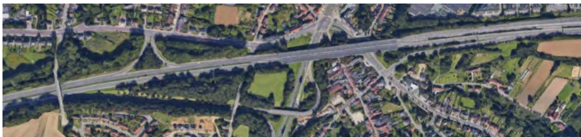
Foto 35: Aansluitingscomplex 20 op de A3/E40 in Kraainem (bron: www.google.be/maps )
