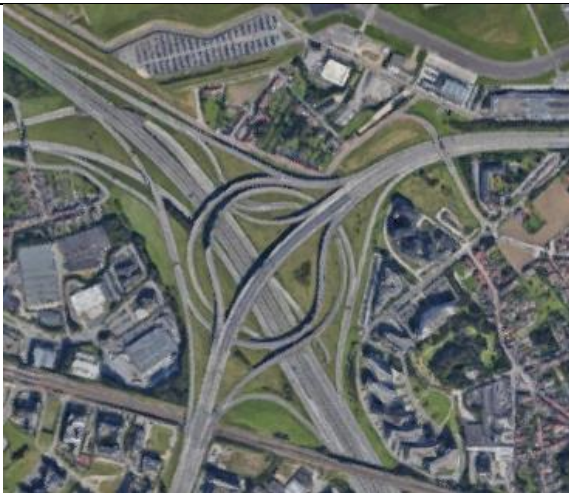
Foto: Aansluitingscomplex R0 x A201 (bron: www.google.be/maps )
