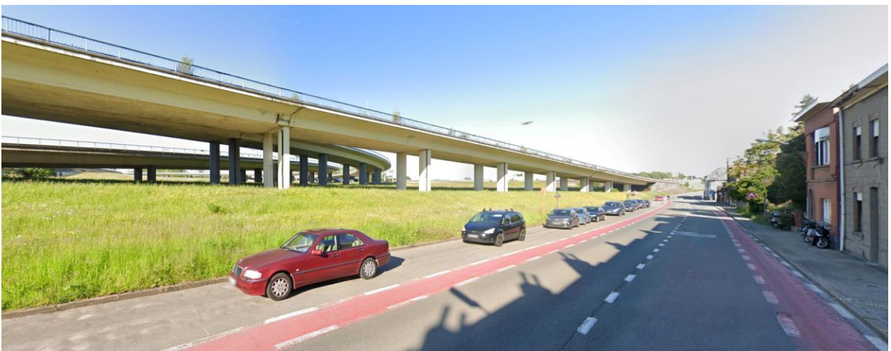
Figuur: Bestaande toestand van de knoop R0x201 , gezien vanuit Diegem-Lo
