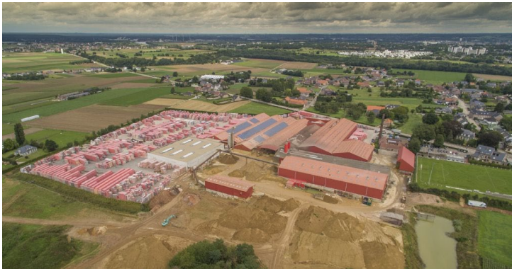
Figuur 2: Vooraan de opslag van de grondstoffen. Centraal de kleine loods waar de kleivoorbereiding gebeurt.
