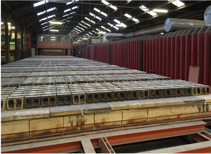
Figuur 4: Rechts één van de 4 tunnelovens. Vooraan lege ovenwagens, klaar om opnieuw volgetast te worden en de oven in te gaan.
