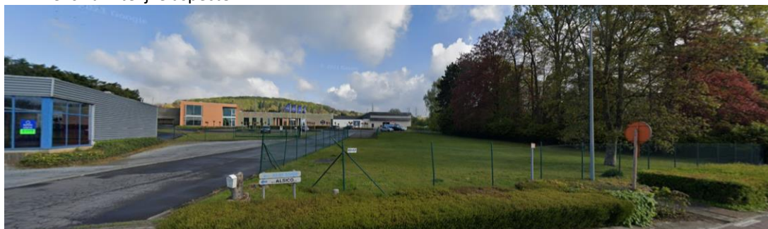
Bedrijf Alsico, geïmpacteerd door tracé C1
