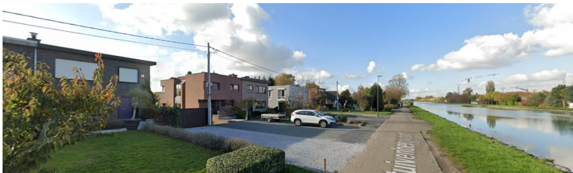
Figuur 13-9 Zicht van het bebouwde gedeelte van de Stuivenbergvaart (Bron: Google, 2020)
