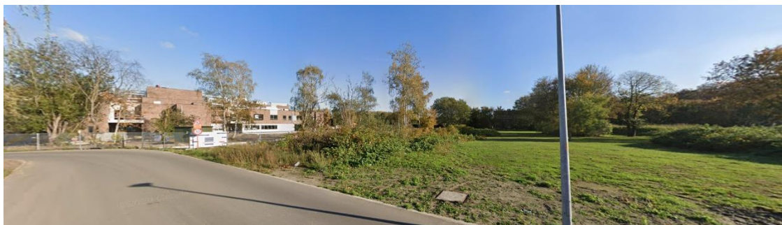
Figuur 13-64 De bouwwerken van het nieuwe WZC en zijn omgeving (Bron: Google, 2020)
