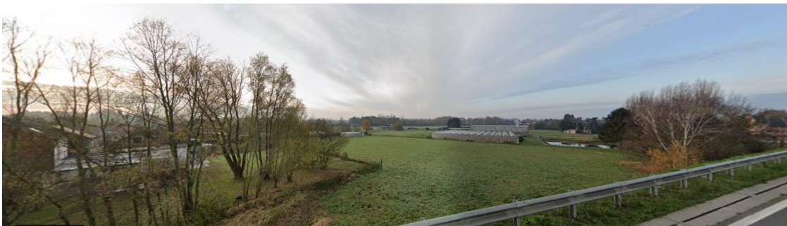
Figuur 13-57 Zicht op het deelgebied vanaf de R6 (Bron: Google, 2020)
