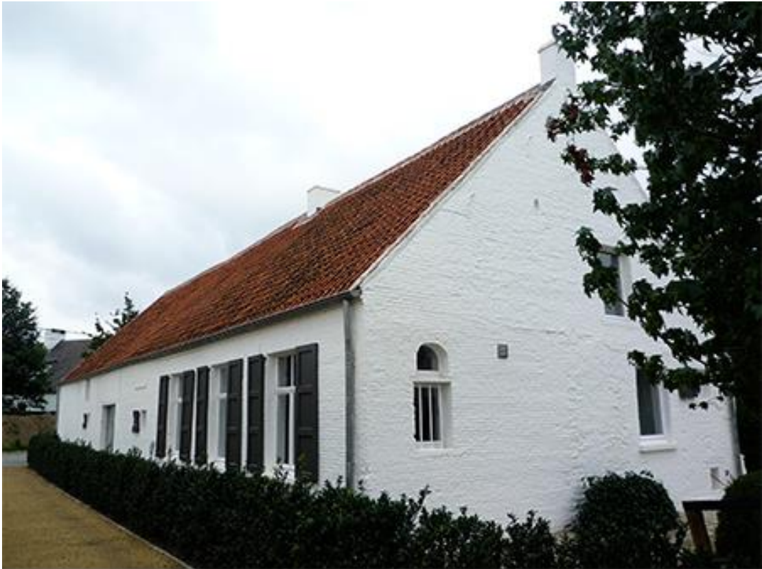
Figuur 12-28 Cretenburghoeve na restauratie (foto: arch. Beeck-Hermans)
