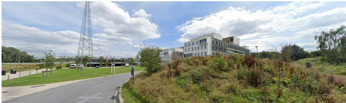
Figuur 13-63 Het ziekenhuis en het parkeergebouw (Bron: Google, 2020)
