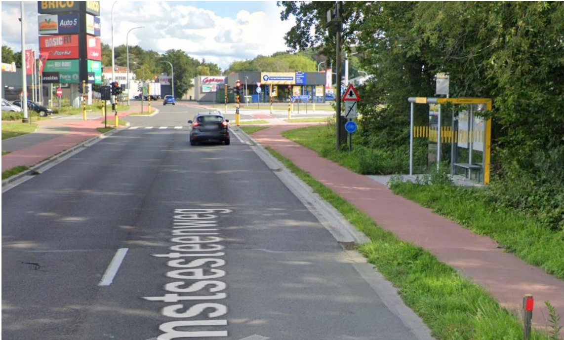
Figuur 6-27 Een fietspad en een kleine grasstrook bemoeilijken het opstappen aan deze bushalte op de Zemstbaan
