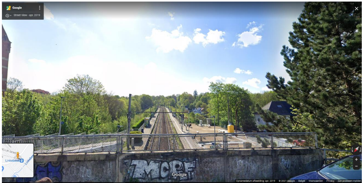
Zicht vanop de brug Stationsstraat/Godshuizenlaan
