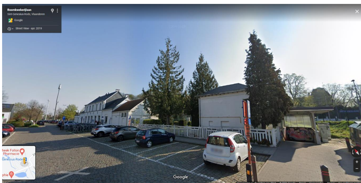
Figur 9-26: Zicht op het seingebouw en betonnen muur vanuit de Boomkwekerijlaan (google streetview)
