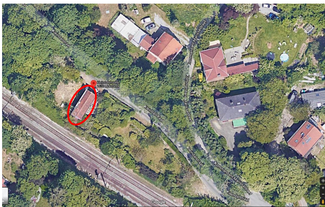
Figuur 10-2: Te verwerven en af te breken woning Kleindalstraat 6
