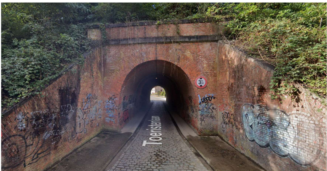
Figuur 12: Tunnel boomkwekerijlaan-toeristenlaan. Bron: Google Street view
